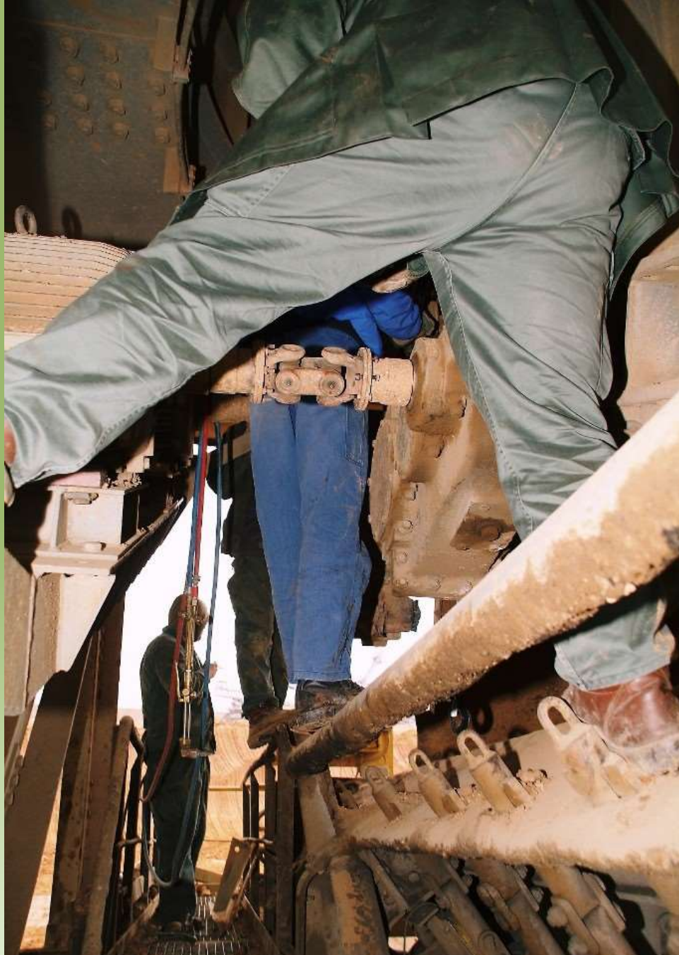
Συντήρηση σε καδοφόρο εκσκαφέα
