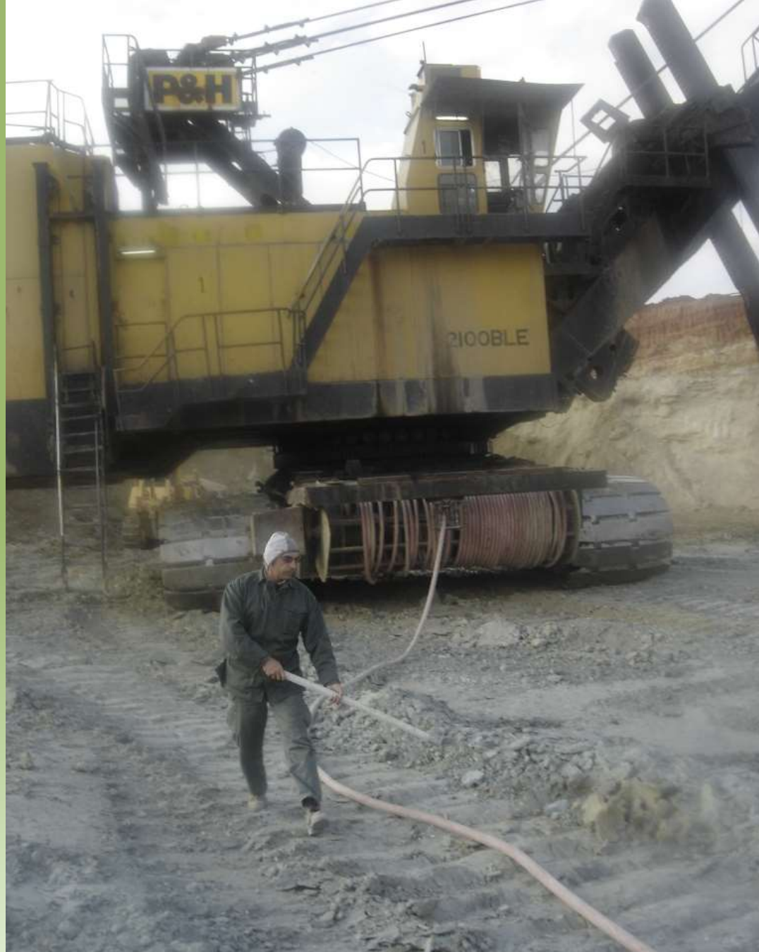
Ηλεκτροκίνητος εκσκαφέας ενός κάδου
