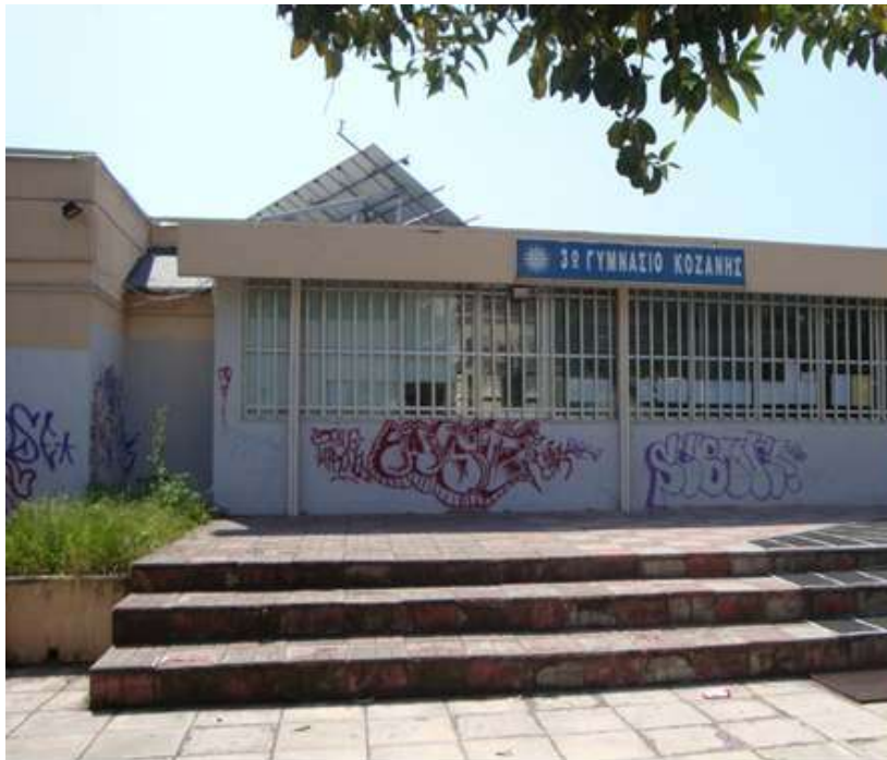
Σχήμα 12.6 Πρότυπο επιδεικτικό έργο εφαρμογών Ανανεώσιμων Πηγών Ενέργειας και Εξοικονόμησης Ενέργειας στο 3ο Γυμνάσιο του Δήμου Κοζάνης
