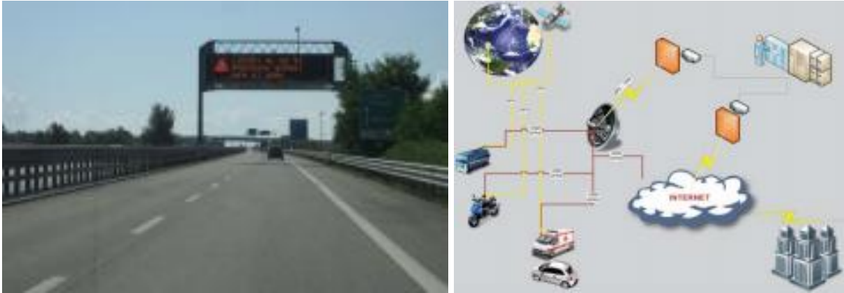
Σχήμα 20.2 Εφαρμογή συστημάτων ευφύων μεταφορών
