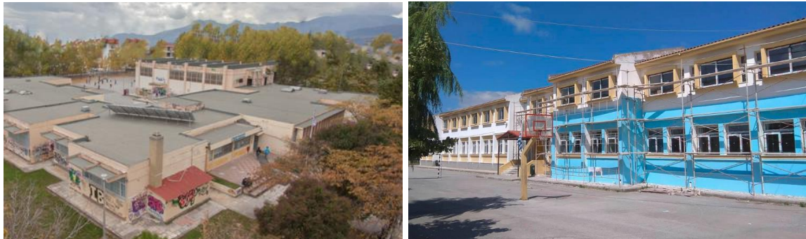
Σχήμα 18.4 Πρότυπο επιδεικτικό έργο εφαρμογών Ανανεώσιμων Πηγών Ενέργειας και Εξοικονόμησης Ενέργειας στο 3ο Γυμνάσιο του Δήμου Κοζάνης
