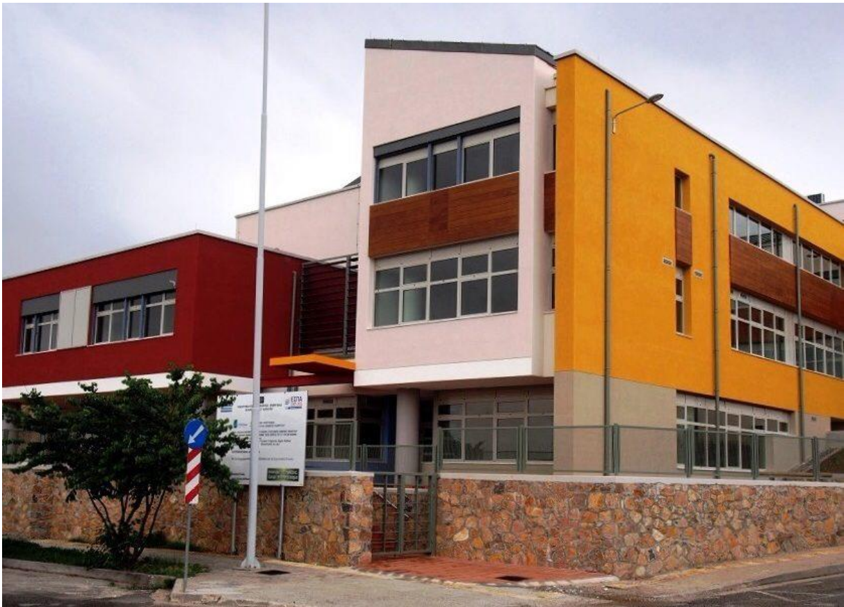
Σχήμα 18.1 Βιοκλιματικό Σχολικό Συγκρότημα Δημοτικού - Νηπιαγωγείου
